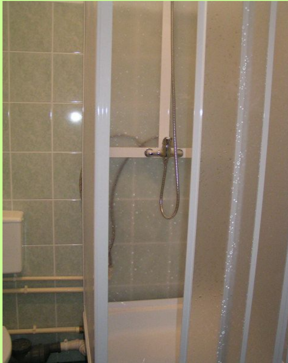
Łazienka (kabina prysznicowa)
